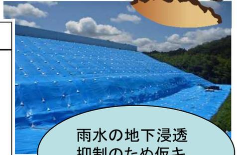
雨水の地下浸透抑制のため仮キャッピングを設置
