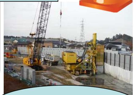
鉛直遮水壁 (TRD) を施工しています
