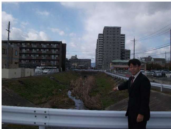
中/井川ショートカット県の改修工事始まる(緒)
