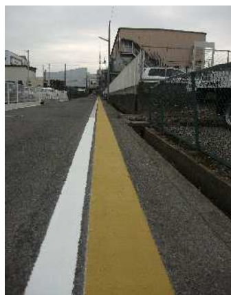
地元自治会要望をいただいた葉山小学校区の危険な通学路のカラー舗装完成(6/19・宅屋自治会)
