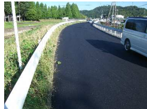
県道川辺御園線(古川橋～恵比寿大黒橋)の道路補修完成し段差や騒音が解消される(6/17・上砥山地先)
